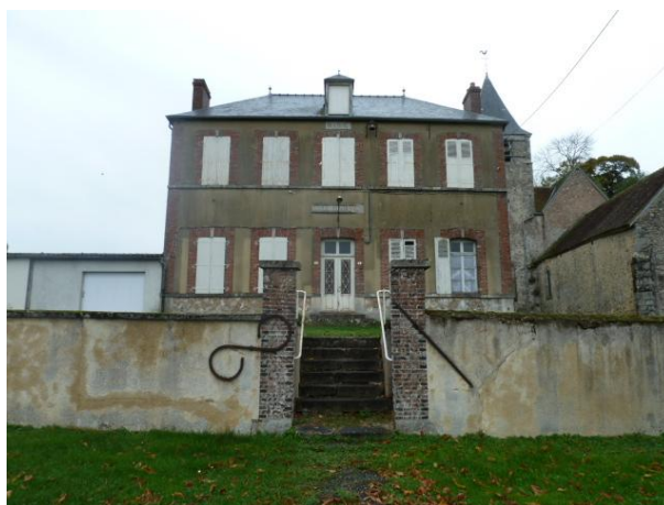
Réhabilitation de l'ancienne mairie de Mœurs en projet
